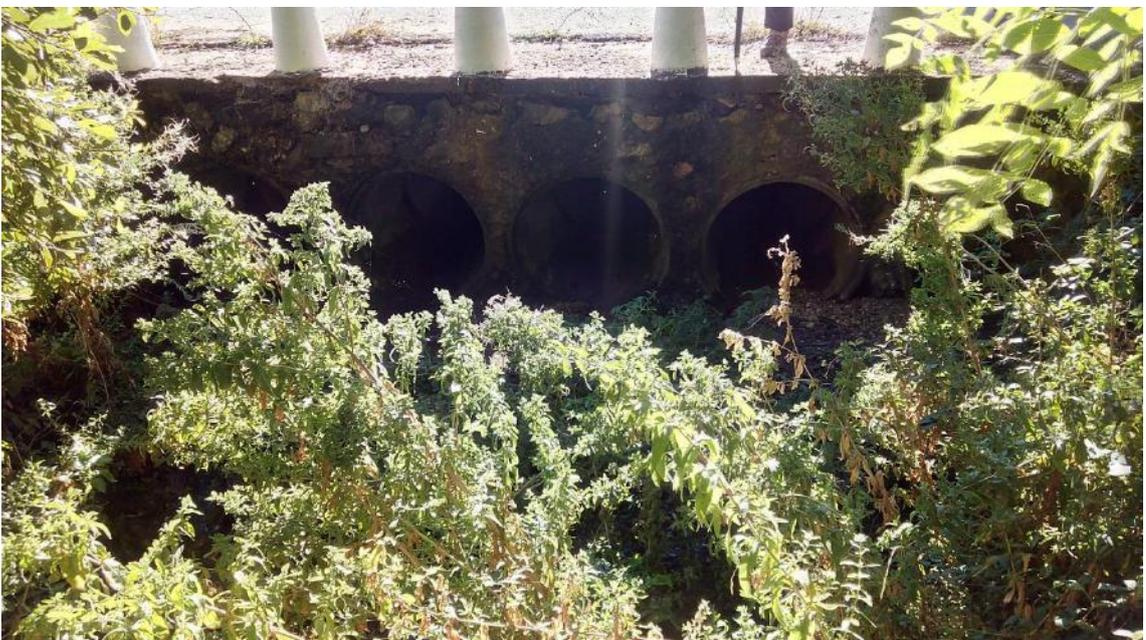
**Figura 12.** Obra de drenaje transversal existente
